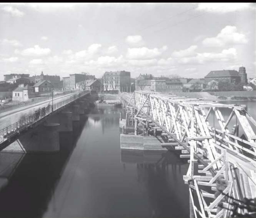
◀ Most Stulecia w trakcie kapitałnego remontu, ok. 1932 r.
