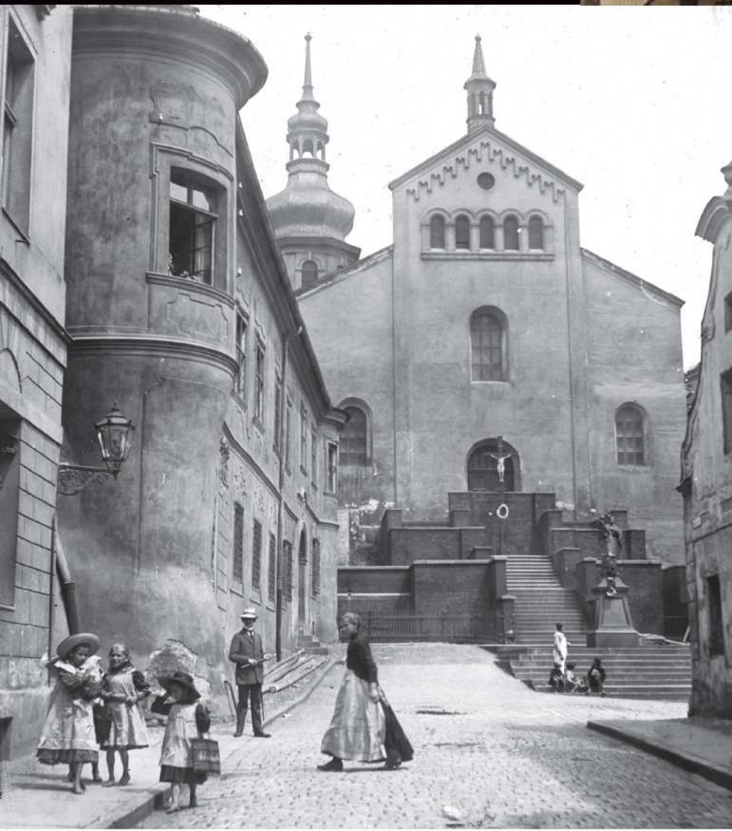
Kościół „Na Górcie” (Bergelkirche) oraz budynek dawnego kolegium jezuickiego, 1911 r.
