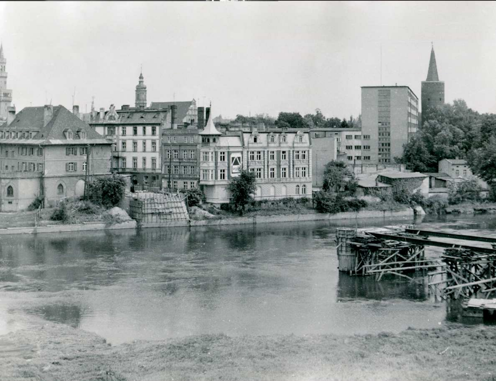
▼ Zniszczony most na Odrze, ok. 1945 r.
