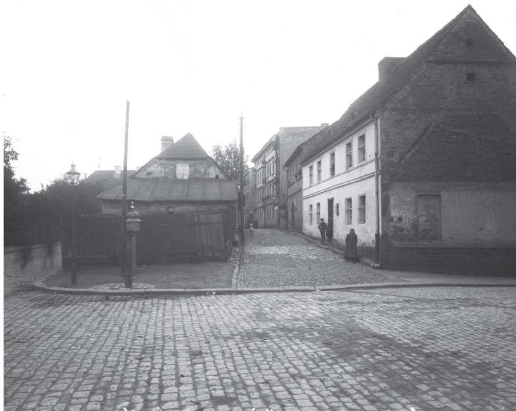
Ulica H. Sienkiewicza, widok po rozbiórce wyspy ABC, ok. 1930 r.
