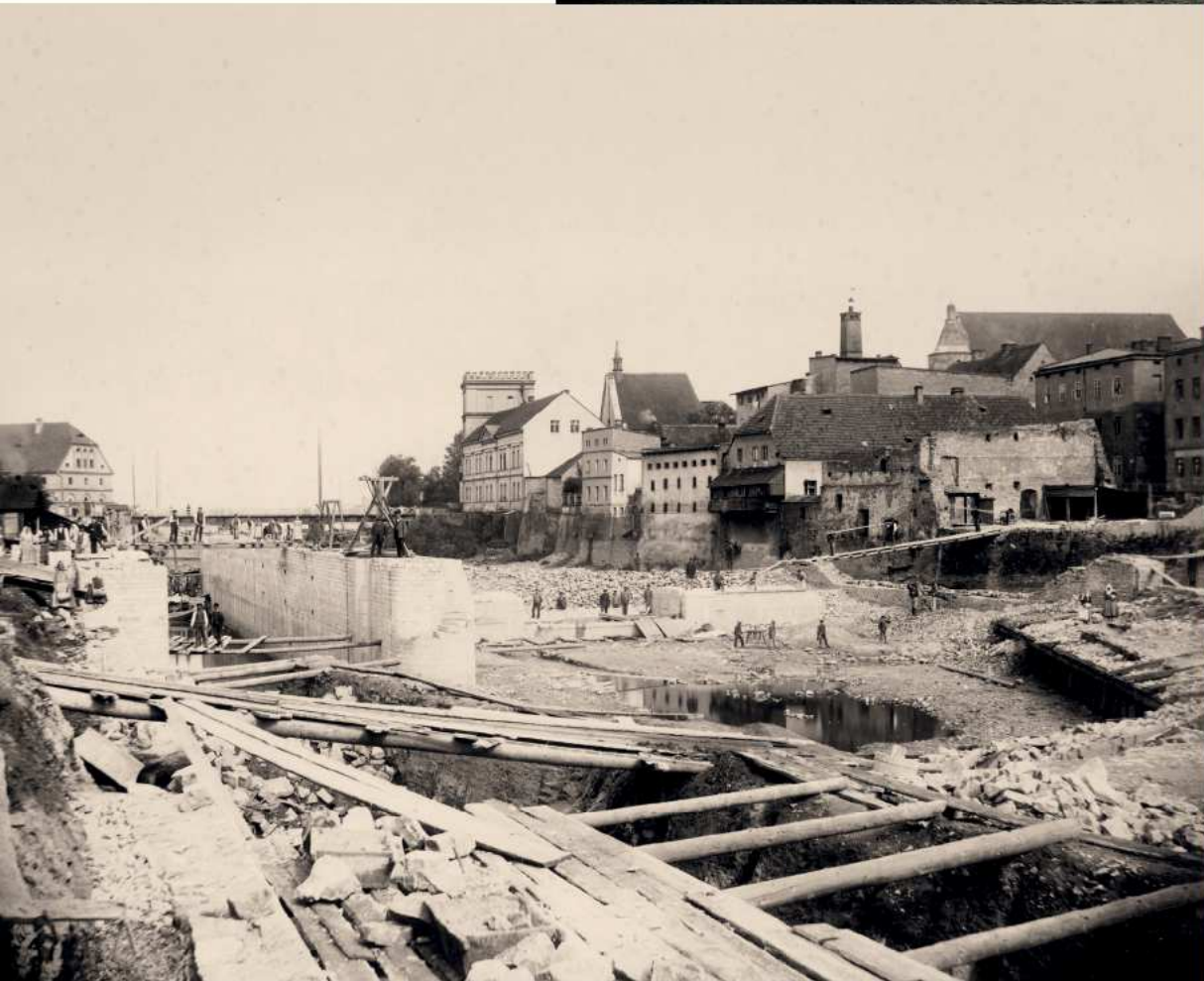
▶ Budowa śluzy żeglugowej i jazu na Młynówce, ok. 1880–1886 r.
