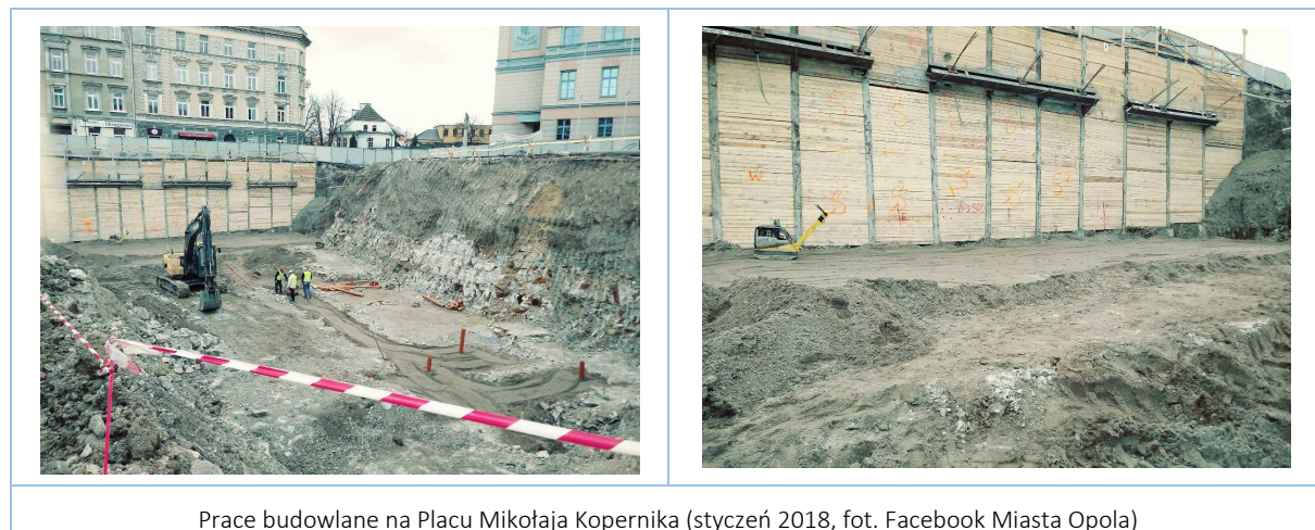
Prace budowlane na Placu Mikołaja Kopernika (styczeń 2018, fot. Facebook Miasta Opola)
