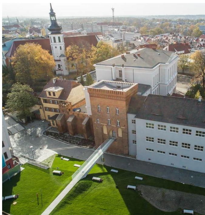
Źródło: fot. ze zbiorów UM Opole. Ryc. 7 Wieża Zamku Górnego z reliktnami murów
