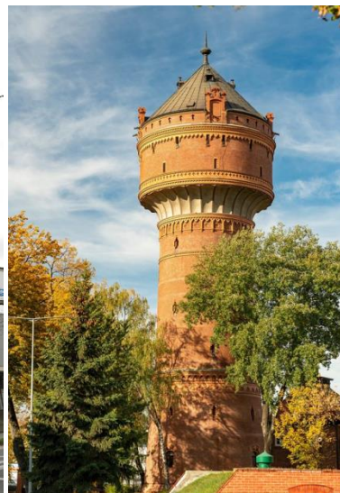
Źródło: fot. za Odkryj Opole. Ryc. 16. Wodociągowa wieża ciśnień
