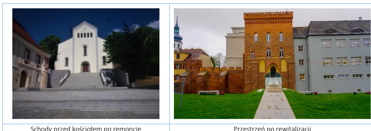
Schody przed kościołem po remoncie
