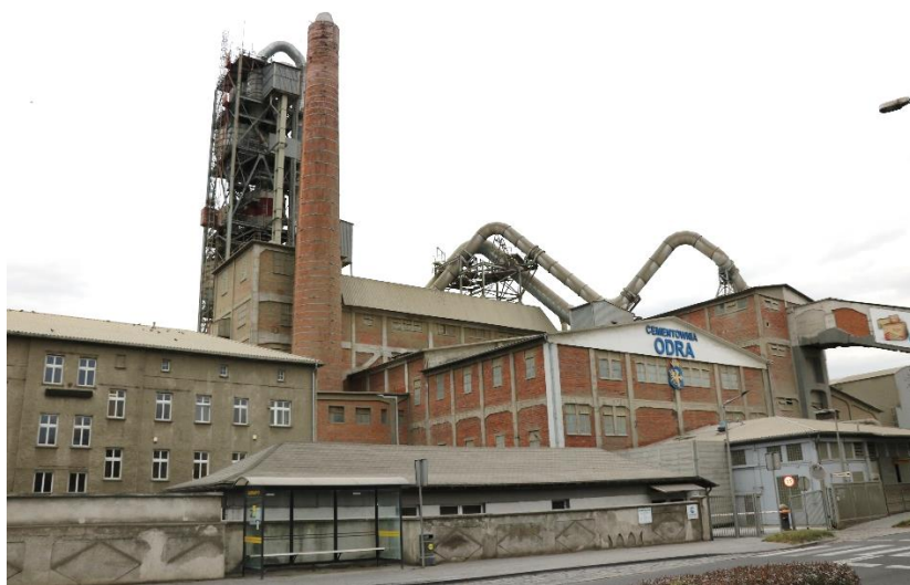
Źródło: fot. I. Solisz. Ryc. 15. Cementownia Odra
