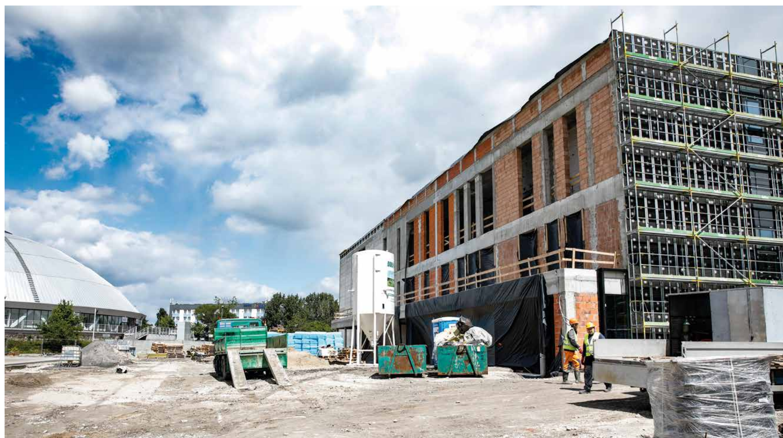
Budowa hali na terenie Opolskiego Parku Sportu, fot. Daria Strąk
