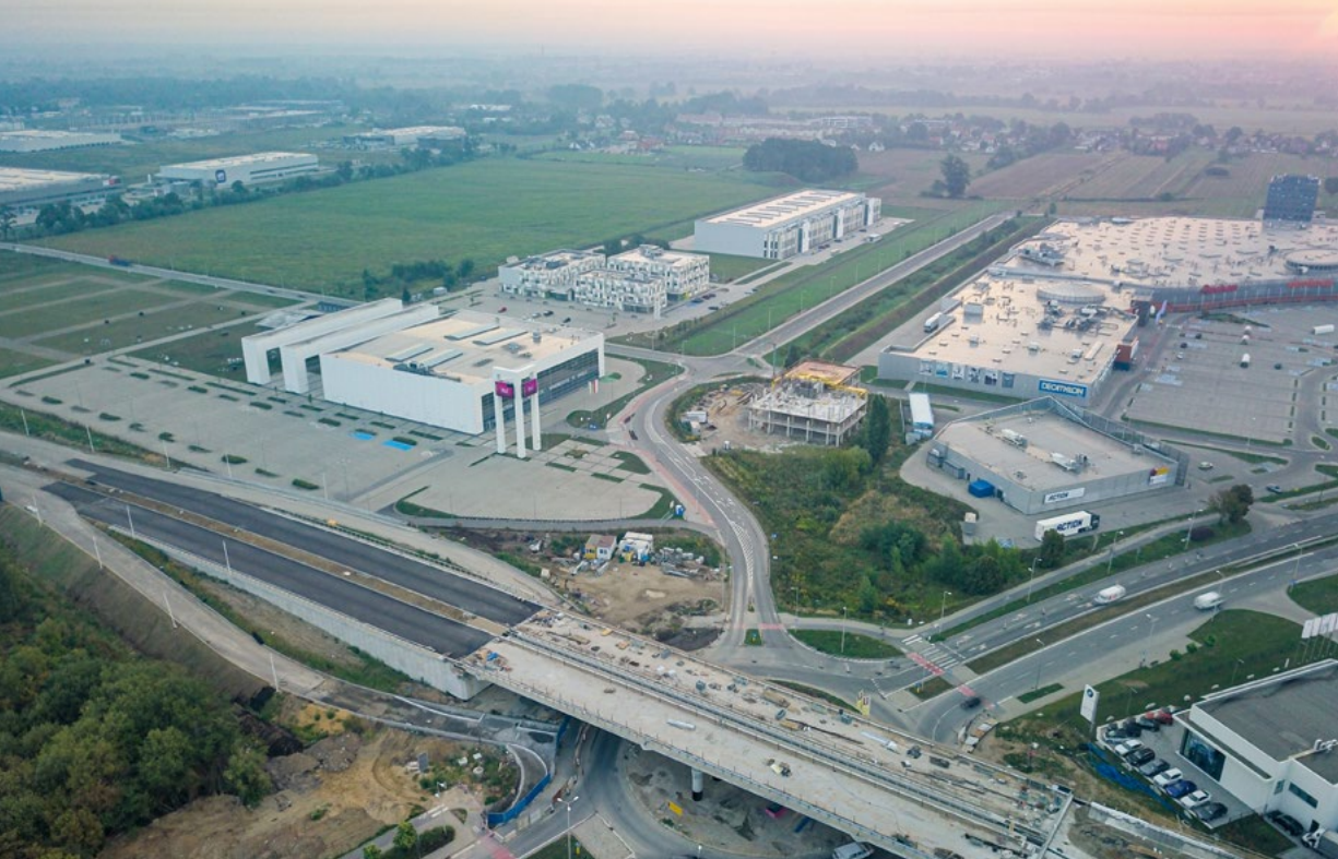
Centrum Wystawienniczo-Kongresowe, Park Naukowo-Technologiczny, Centrum Handlowe Karolinka oraz budowana obwodnica
