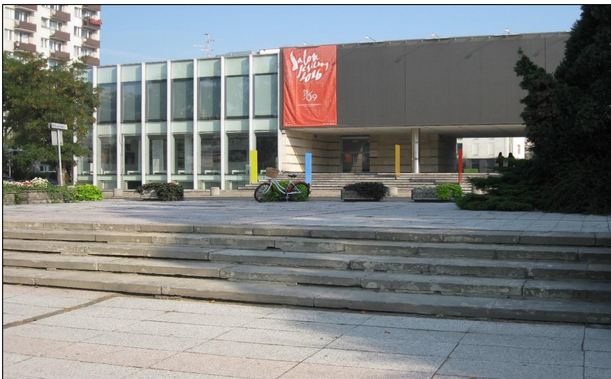
Zdjęcie 14. Zły stan techniczny przestrzeni publicznych (plac Jana Pawła II).
