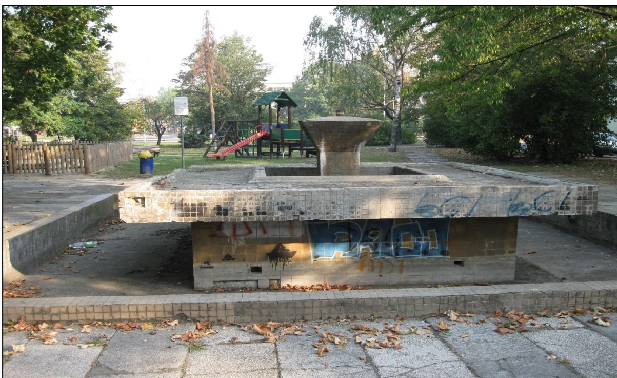
Zdjęcie 15. Zły stan techniczny przestrzeni publicznych (ulica Pułaskiego).
