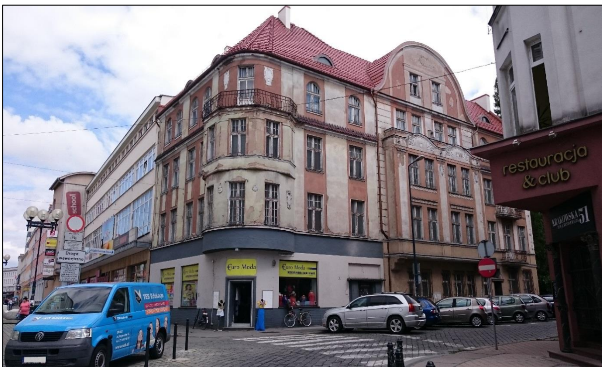
Zdjęcie 13. Zły stan techniczny części budynków (w tym obiektów zabytkowych).
