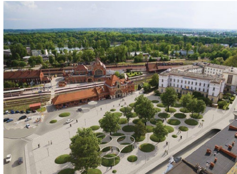
Przebudowa placu przy Dworcu Głównym
