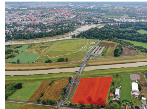
Budowa parkingu przy Wyspie Bolko
